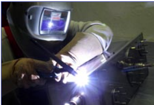
Schweißarbeiten am VW-Benzinnottank
